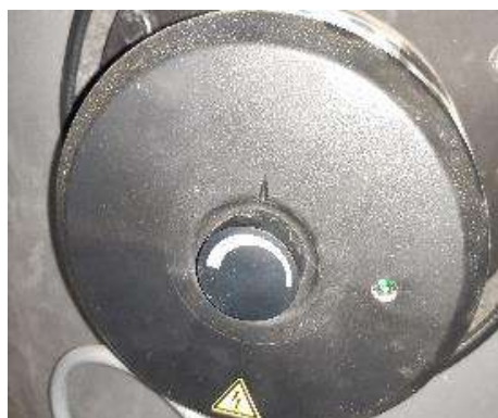
Abb. 3: Heizstab mit Thermostatschalter ohne Temperaturanzeige.
